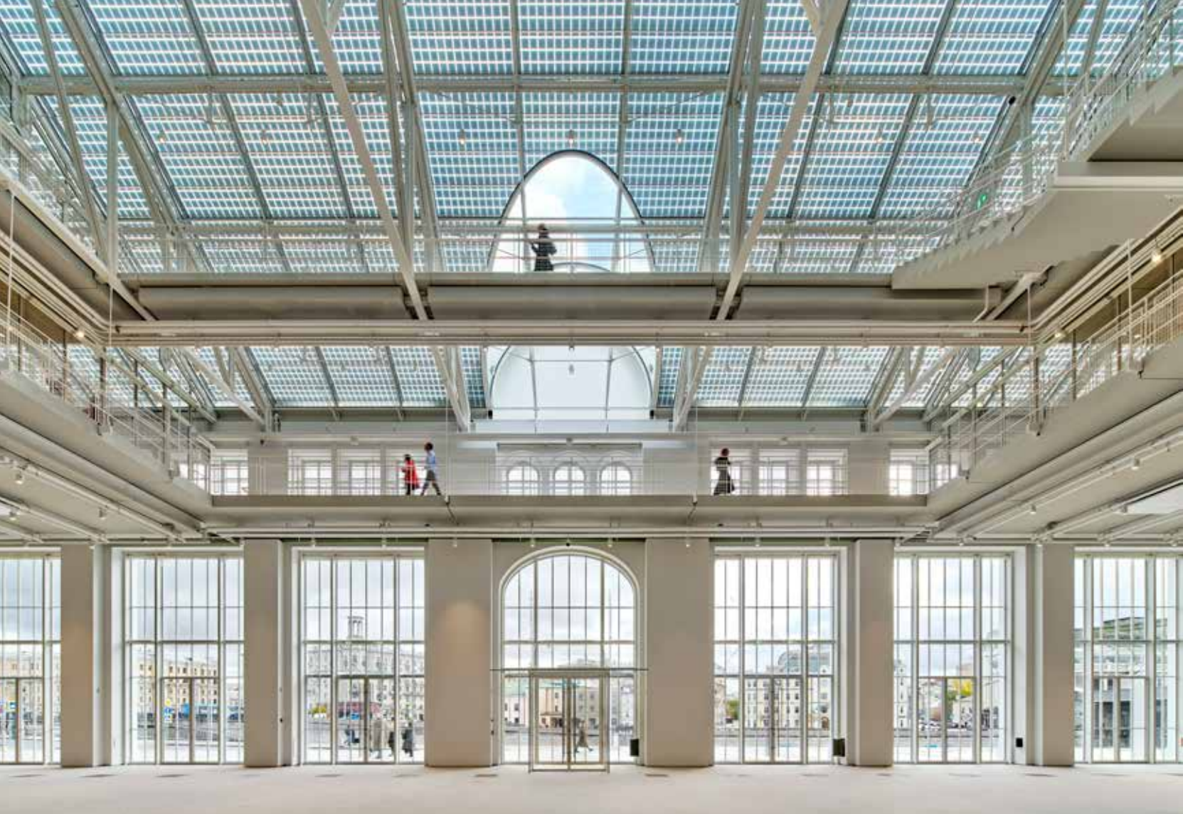
Sopra, la lunga navata laterale rivolta verso la città. Il lato opposto affaccia invece su un bosco di betulle voluto e progettato da Piano, che allo scopo ha fatto acquistare e demolire alcuni edifici addossati all'ex centrale elettrica. Sotto, la vecchia consolle di comando, una memoria industriale conservata. Nella pagina accanto, Renzo Piano ritratto lo scorso dicembre durante l'inaugurazione di GES-2. ● Above, the long aisle facing onto the city. The opposite side faces onto a grove of birch trees designed by Piano on the site of a number of buildings located next to the former power station which have been demolished for the purpose. Below, the old control console, a memory of the industrial past that has been preserved. Opposite page, Renzo Piano at the opening of GES-2 last December.
